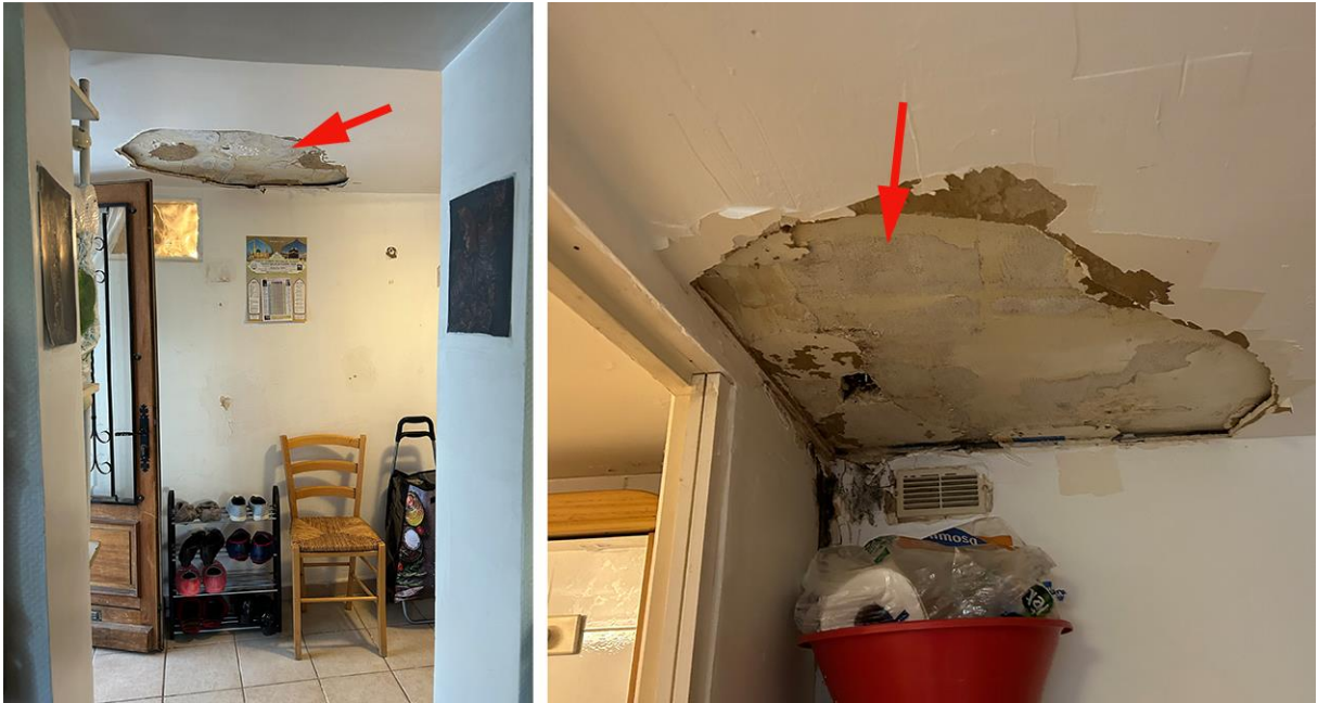
Plafond du logement en entresol
