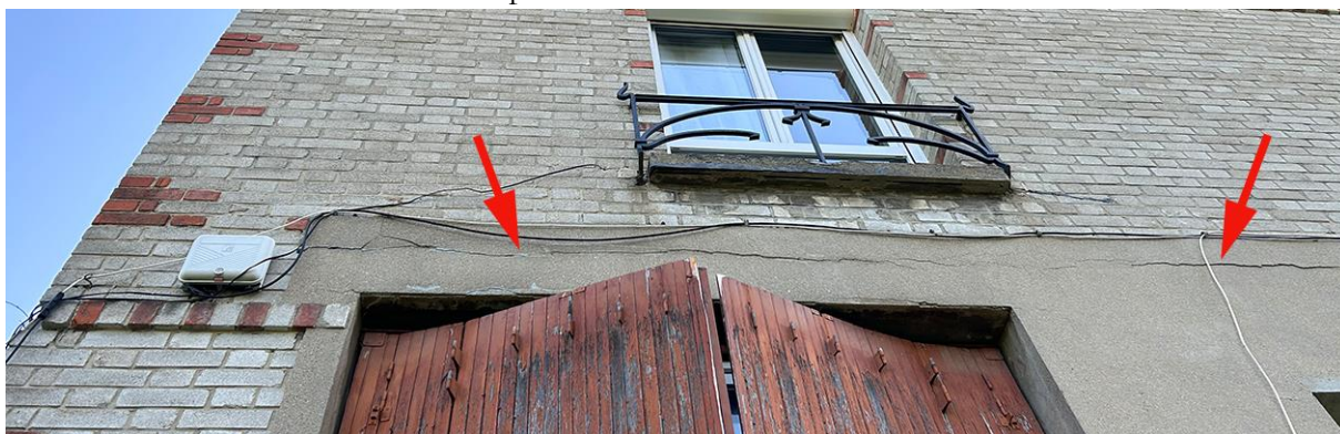
Linteau sur le pignon dans le passage
