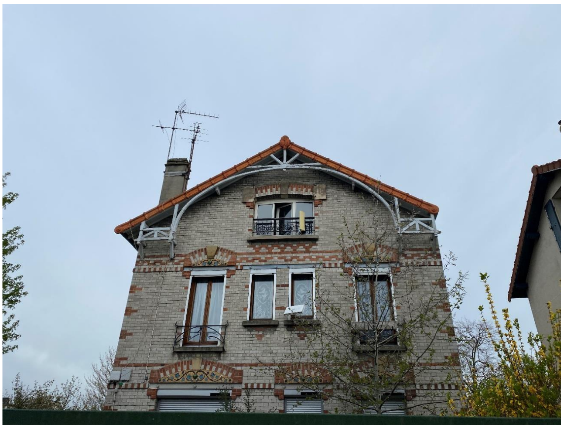
Façade rue du bâtiment
